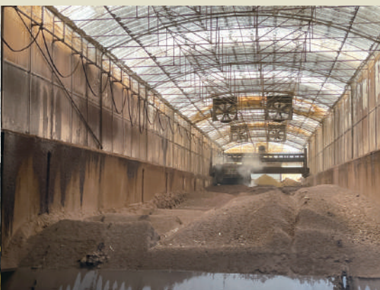
義竹場發酵區 自動翻堆機每天定時運作，配合底部強制的曝氣系統，確保氧氣能均勻進入堆體的每一吋
